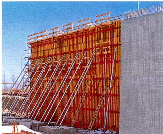
Pareti, alte 10,20 m di un parcheggio, realizzate con unità costituite da 2 moduli VARIO sovrapposti.
