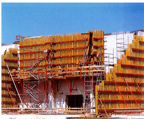
La trave GT 24 è in grado di adattarsi perfettamente alla forma architettonica delle opere in costruzione.
