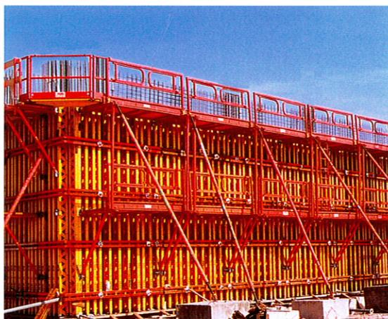
Moduli standard VARIO GT 24 di altezza pari a 6,00 m con piattaforme di servizio per la costruzione di un centro fieristico.
